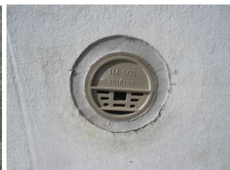
ウィープホール設置・完了写真
