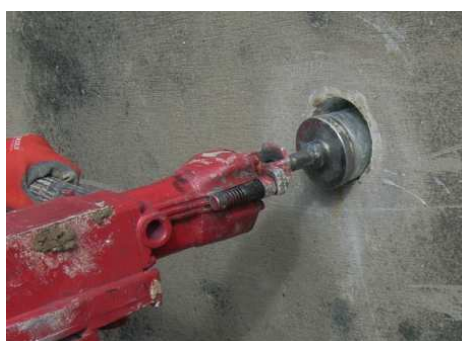
集水管打ち込み状況写真
