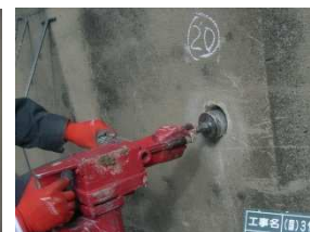
写真-27 鋼製集水管 写真-28 打ち込み状況
