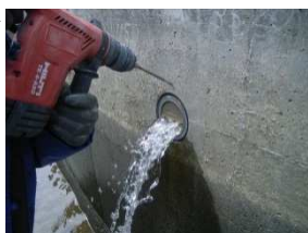
写真-24 注入孔削孔
