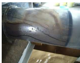
写真-15 洗浄状況
