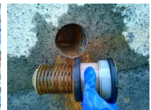
写真-22 洗浄状況
