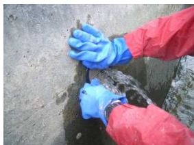
写真-23 挿入状況
