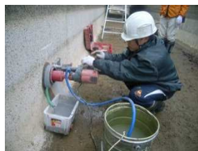
写真-6 コア削孔
