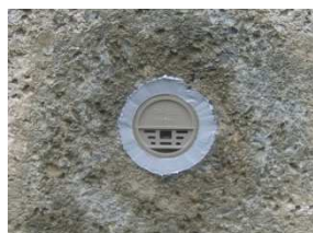
写真-24 コーキング仕上げ
