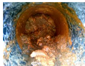
写真-21 背面状況
