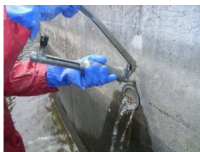
写真-26 注入状況
