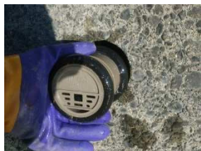
写真-8 ウィープホール挿入
