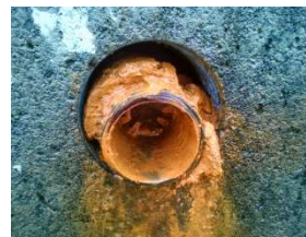
写真-19 ウィープホール取外し
